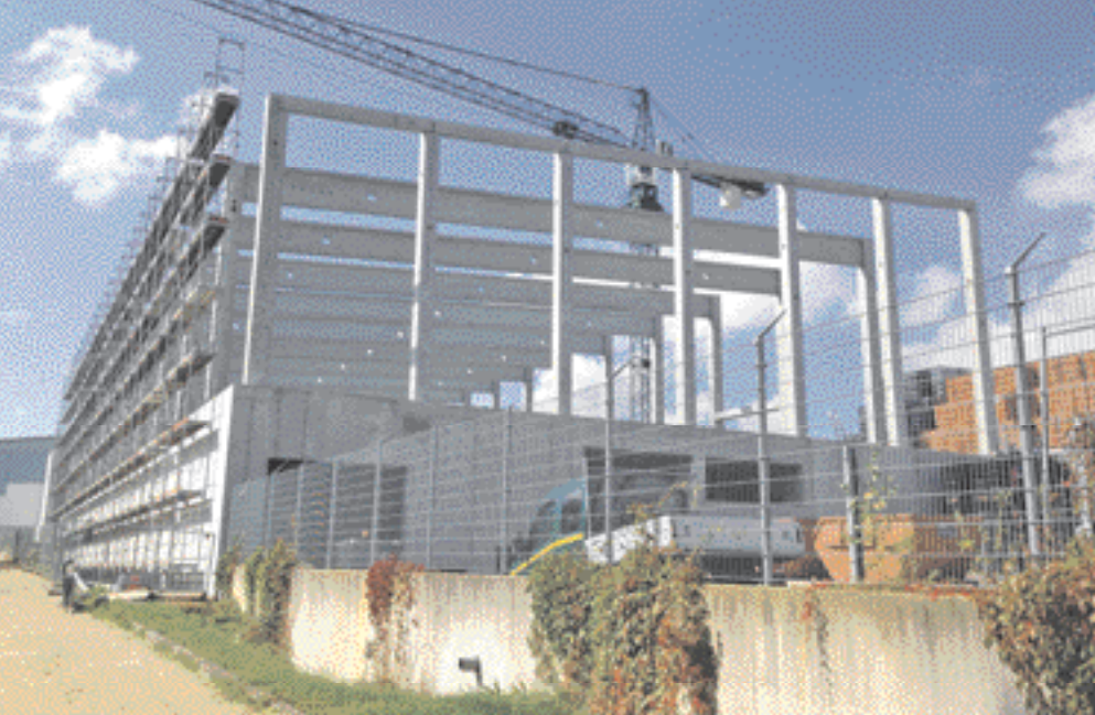
Bauabschnitt V während der Bauzeit
