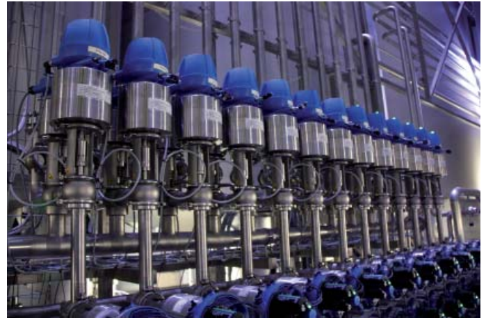
Ventilblock für die Steuerung der Drucktanks
