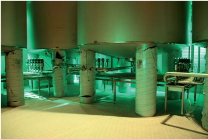
Die Tankfüße wurden nach dem Ausrichten verdübelt und untergossen
