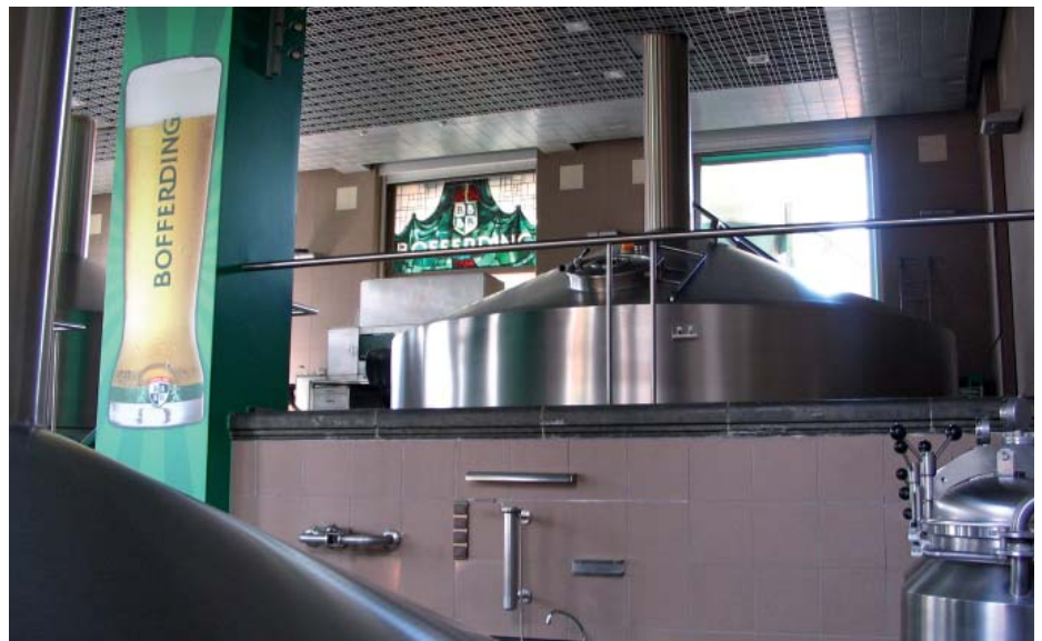
Sudhaus der Brauerei Bofferding, Bascharage
